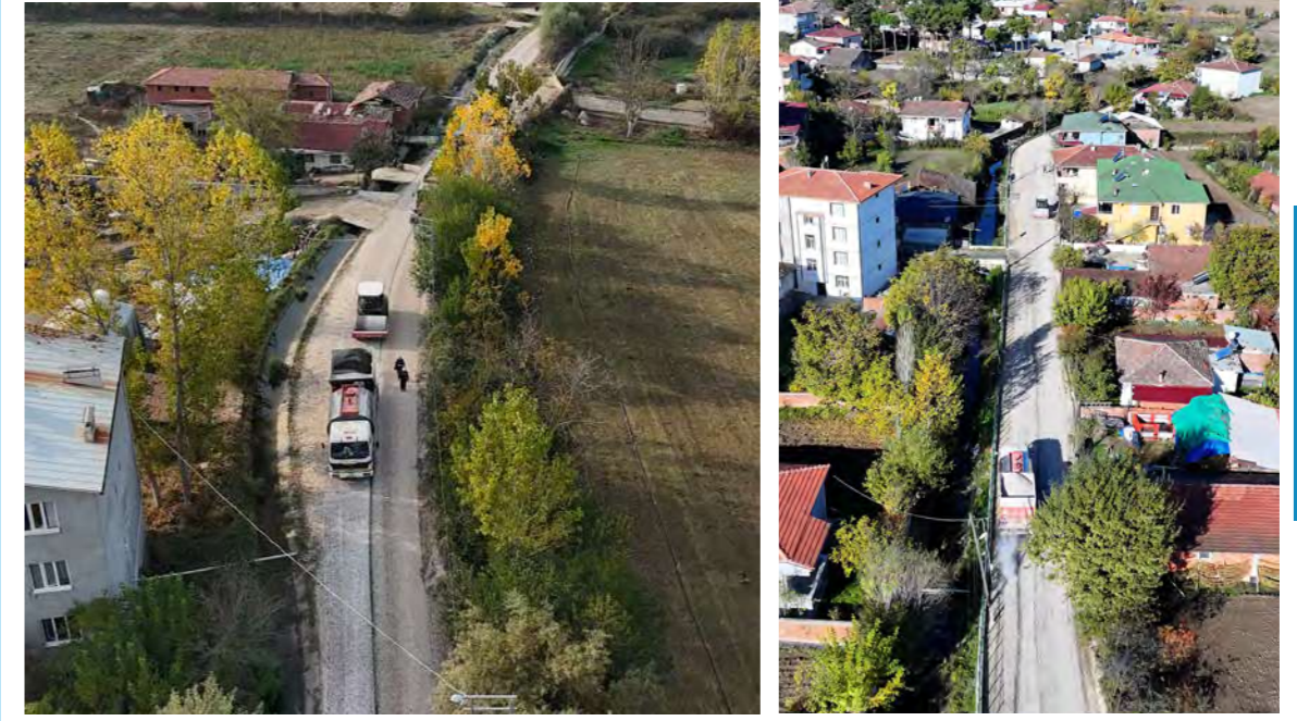
Erbaa ilçe sınırlarında 50.000 m2 emisyonlu sathı kaplama çalışması yapıldı.
