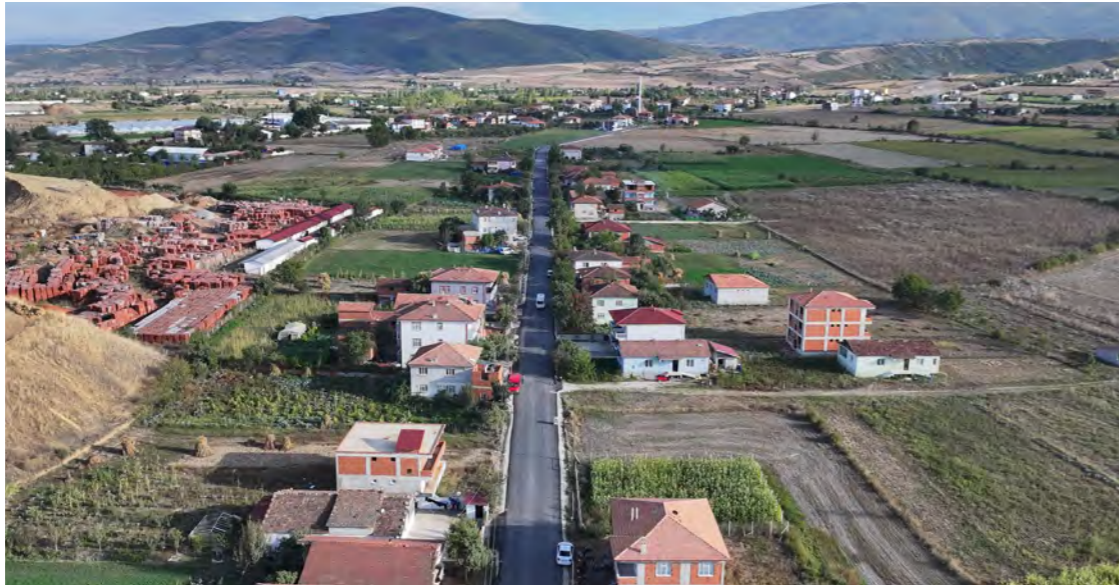
Kuruçay Mahallesi Eski Tokat Yolu 18.500 m2 sıcak asfalt serimi yapıldı.
