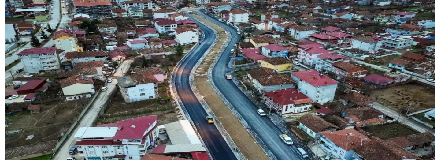
Yunus Emre Mahallesi Asfalt Çalışması
