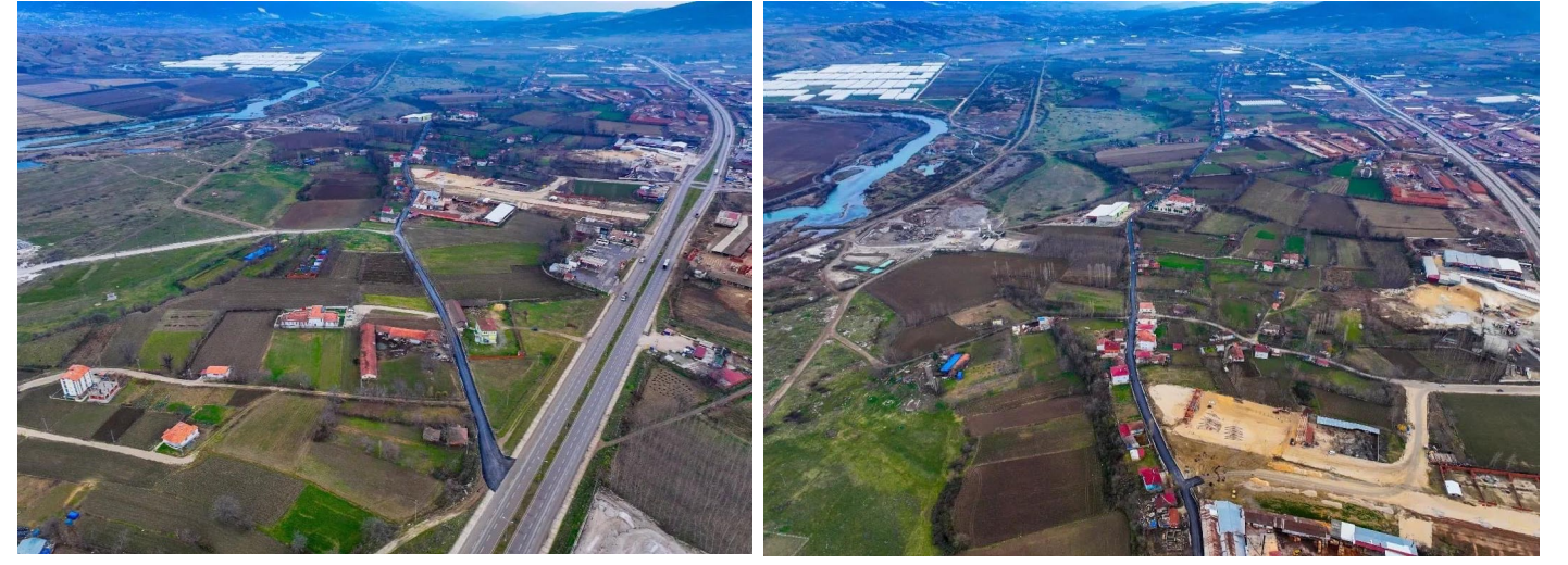
Yeni Mahalle Asfalt Çalışması
