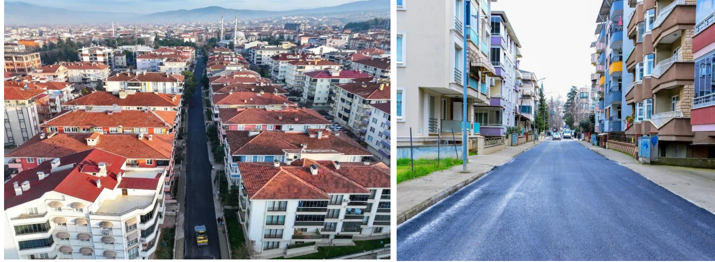
Fevzipaşa Mahallesi Asfalt Çalışması
