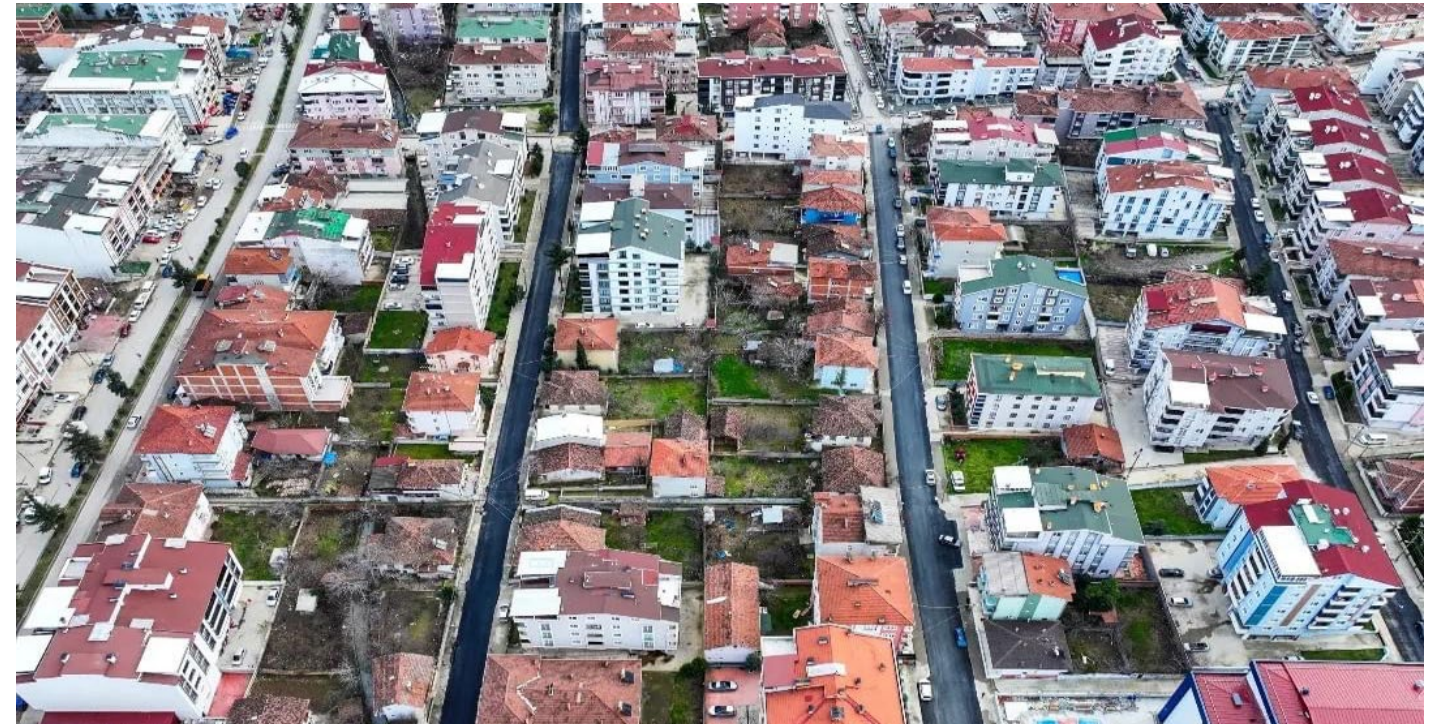
Mehmet Akif Mahallesi Asfalt Çalışması
