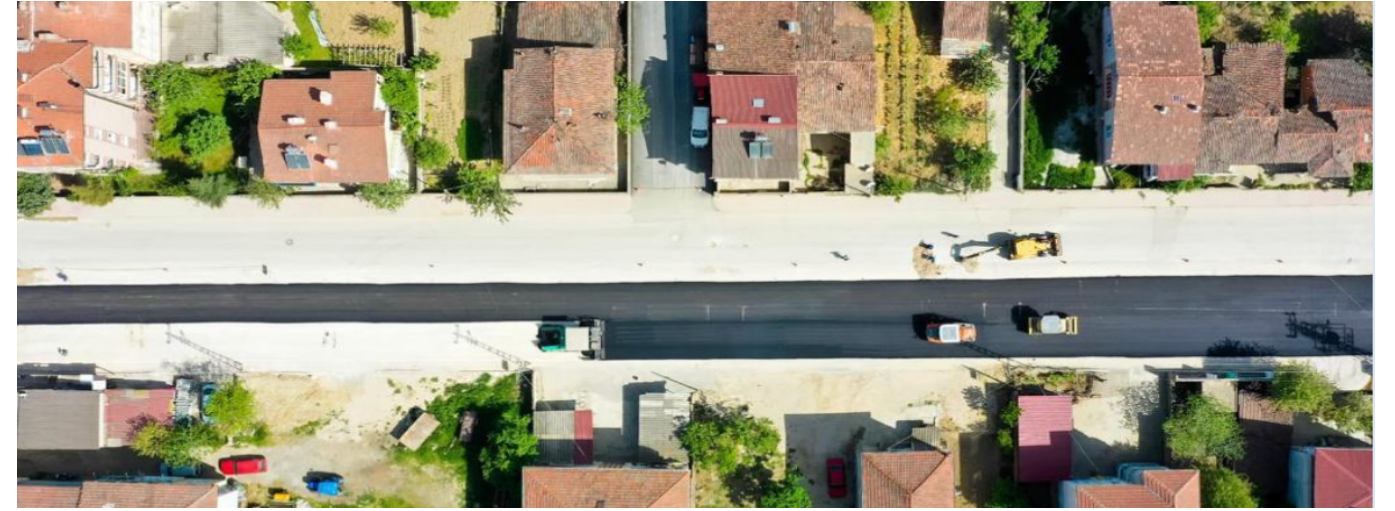
GOP mahallesi hızarcılar caddesi sıcak asfalt serimi yapıldı.
