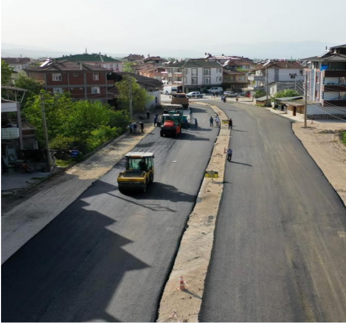
Yıldırım Beyazıt mahallesi Orhangazi caddesi sıcak asfalt serimi yapıldı.
