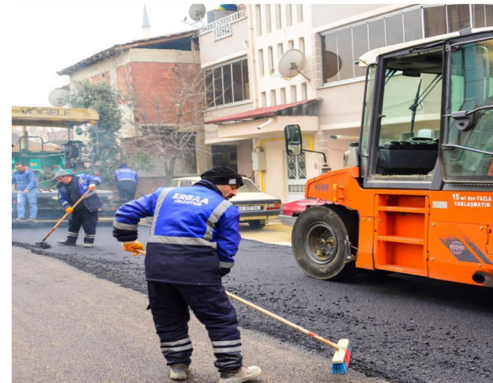
GOP mahallesi Aydın sokak Mezbaha sokak sıcak asfalt serimi yapıldı.
