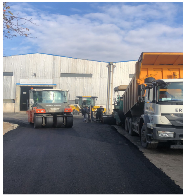
Erbaa Belediyesi Makine İkmal Şefliği sahasına sıcak asfalt serim işlemi yapıldı.
