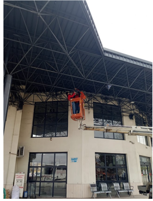
Otogar binasında yapılan yenileme çalışmaları kapsamında elektrik tesisatı ve aydınlatma çalışmaları tamamlanmıştır.
