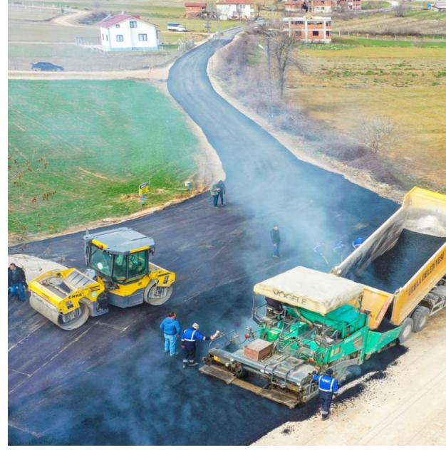
Kuruçay Mahallesi İkbâl sokak sıcak asfalt serimi yapıldı.
