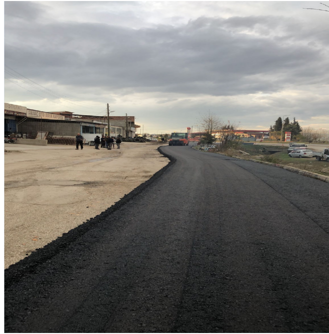
Erbaa Küçük Sanayi Sitesi sıcak asfalt döküm işlemi yapıldı.
