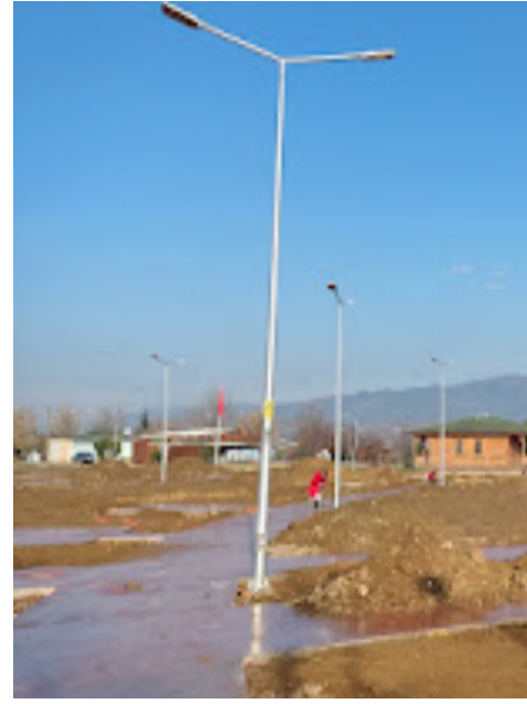
Parkvadi Millet Bahçesi kapsamında elektrik altyapısı çalışmalarına başlanmıştır.
