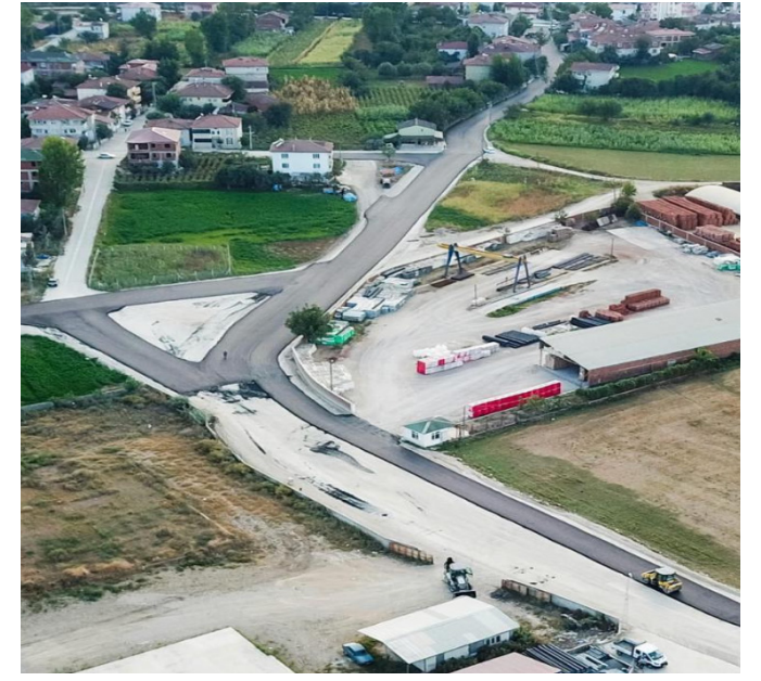
Yıldırım Beyazıt Mahallesi Mehmetçik caddesi sıcak asfalt serimi yapıldı.
