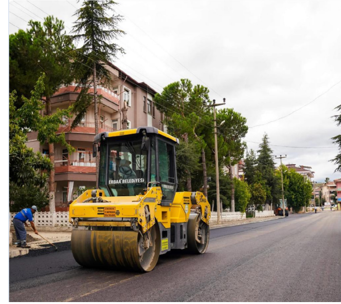
Niyazi Kanbolat caddesi (Çarşamba Pazarı) sıcak asfalt serimi yapıldı.
