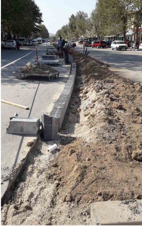
Bordür Dizme Çalışmaları
