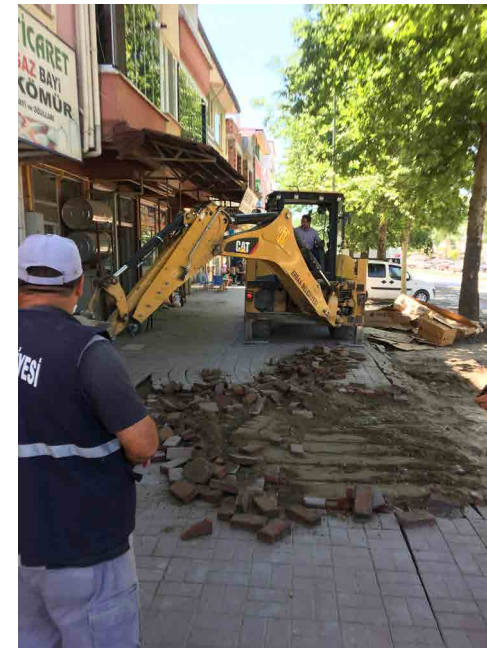
Eski Kaldırım Sökme Çalışmaları
