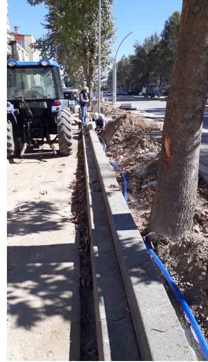
Sulama Sistemi Döşeme Çalışmaları
