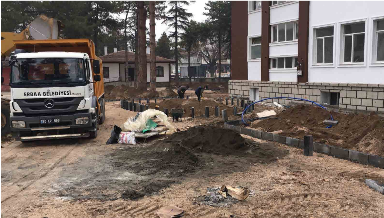
Sulama Sistemi ve Bordür Döşeme Çalışmaları
