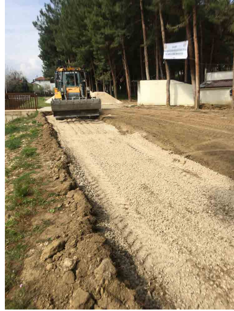
Toprak Tesviyesi ve Sert Zeminlerin Hazırlanması
