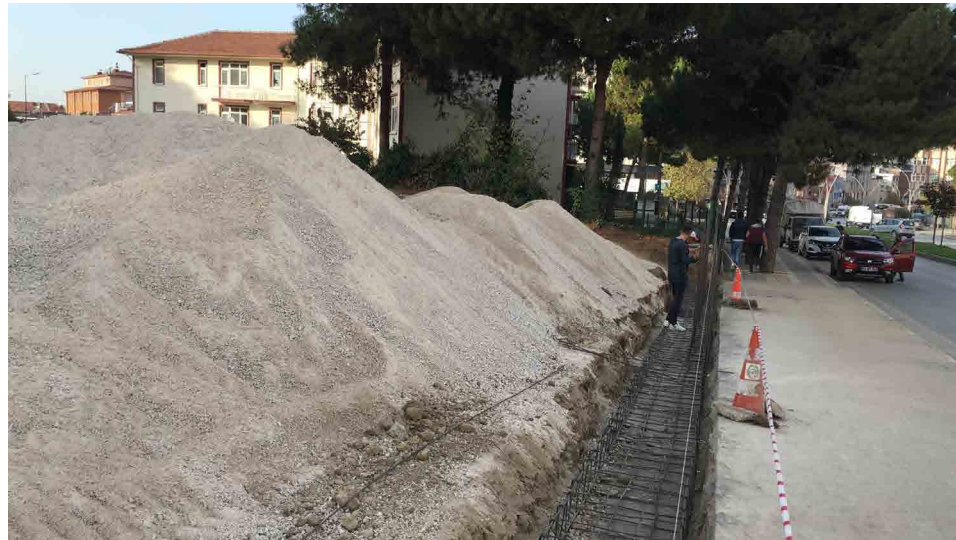
Duvar Yapımı İçin Beton Dökümü
