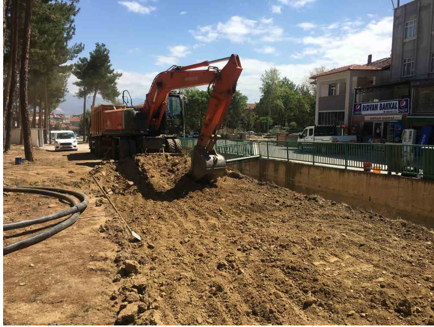
Toprak Tesviyesi ve Sert Zeminlerin Hazırlanması
