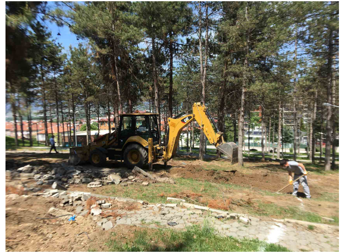
Eski Taşların Sökümü
