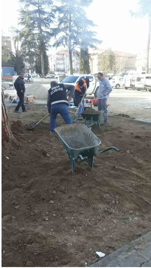
Toprak Tesviye Çalışmaları
